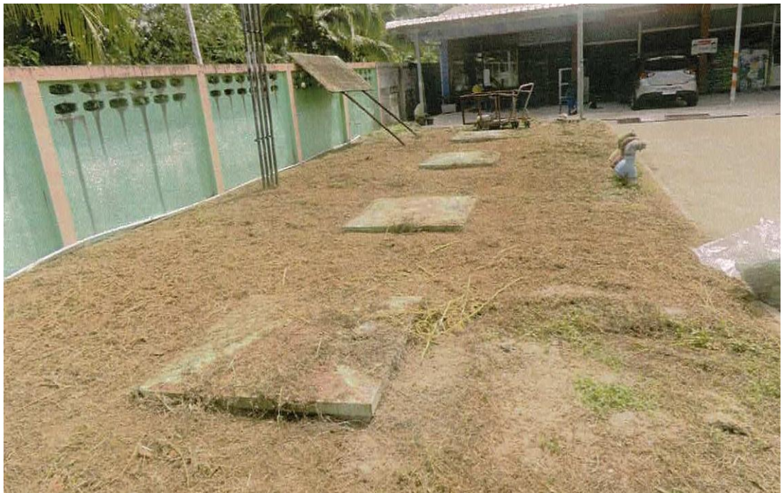
ถังเก็บน้ำมันใต้ดิน ชั้นทะเบียนลำดับที่ 5
